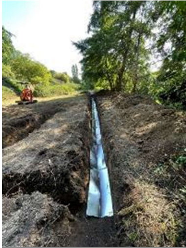
Figure 21 : Installation de la mousse de protection dans la tranchée
