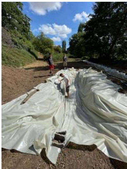
Figure 21 : Installation de la mousse de protection dans la tranchée
