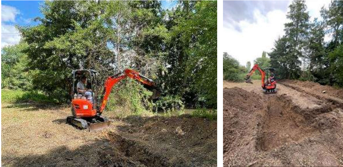
Figure 18 : Photos de la préparation de la tranchée et du réservoir
