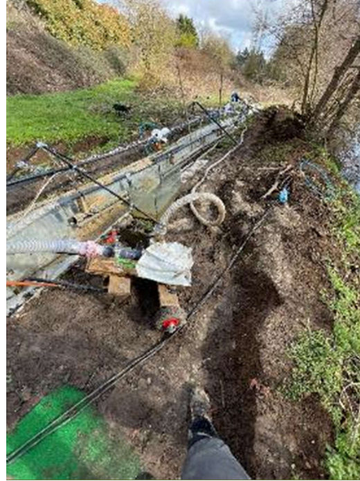
Figure 97: Mars 2023 - prototype dans la tranchée
