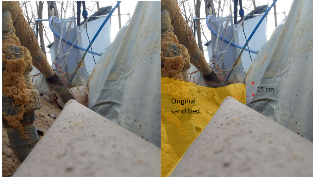
Figure 100: vue du tuyau enfoncé dans la tranchée
