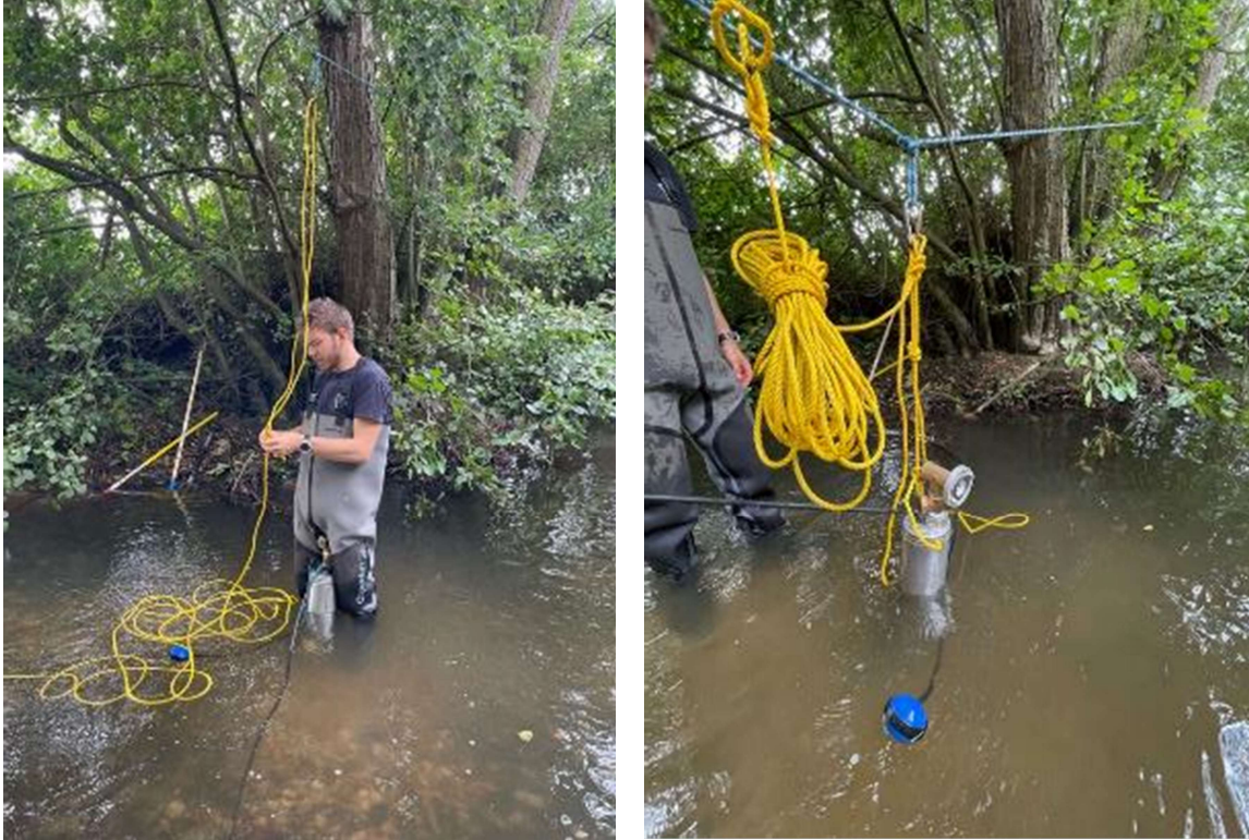
Figure 25 : Installation de la pompe dans la rivière
