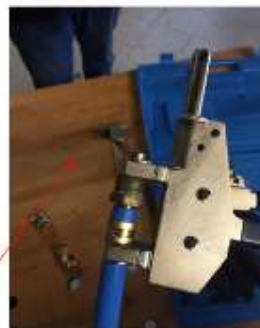
Pose du bouchon
