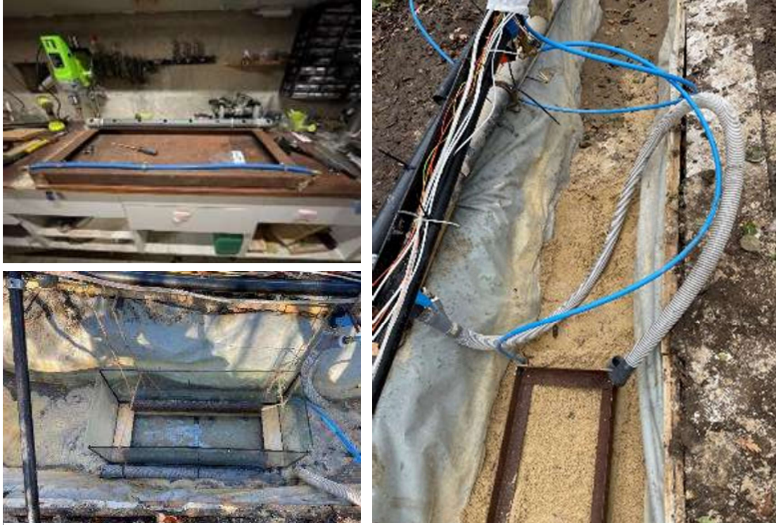
Figure 86 : Armatures en metal
