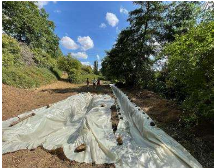
Figure 19 : Pose de la bâche dans la cuve et rendu final
