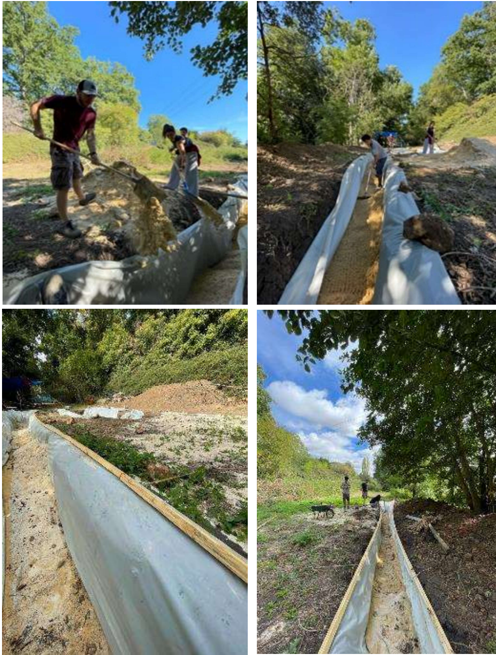
Figure 24 : Remplissage de la tranchée
