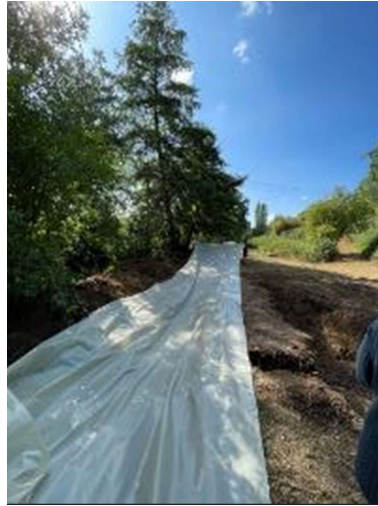
Figure 20: Pose de la bâche dans la tranchée
