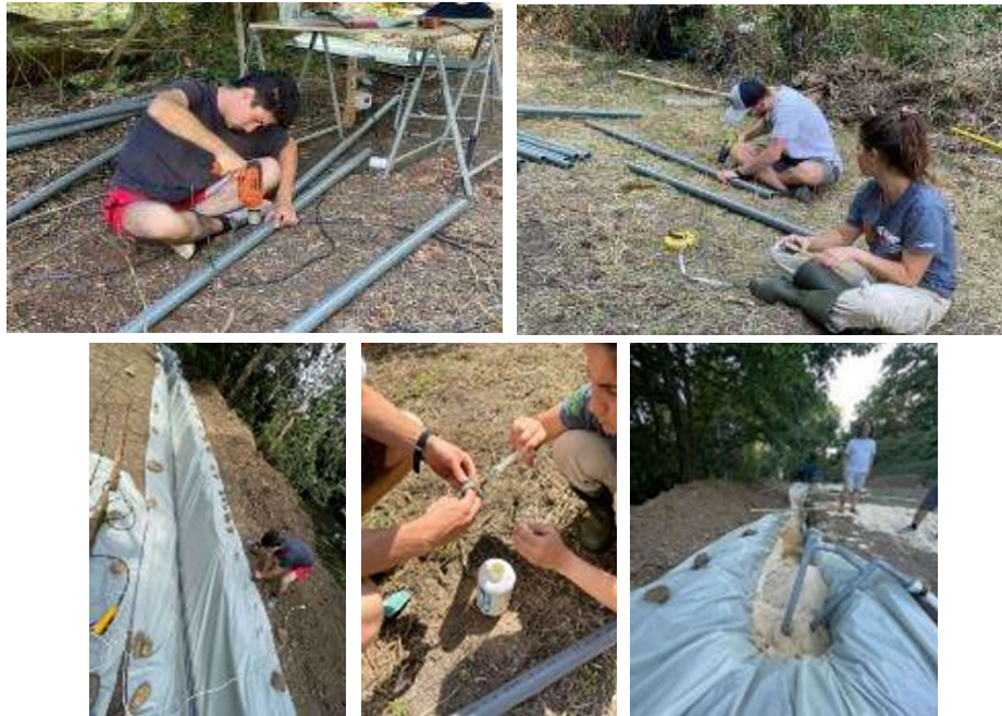
Figure 23 : Perçage de trous d'injection, collage de raccords PVC et enduit.
