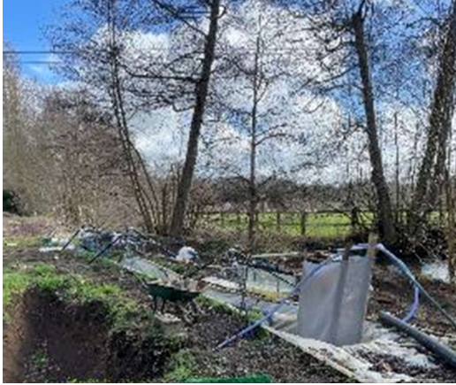
Figure 95: Mars 2023 - prototype dans la tranchée
