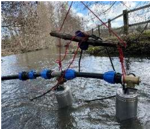
Figure 96: Mars 2023 - 2 pompes installées dans la rivière
