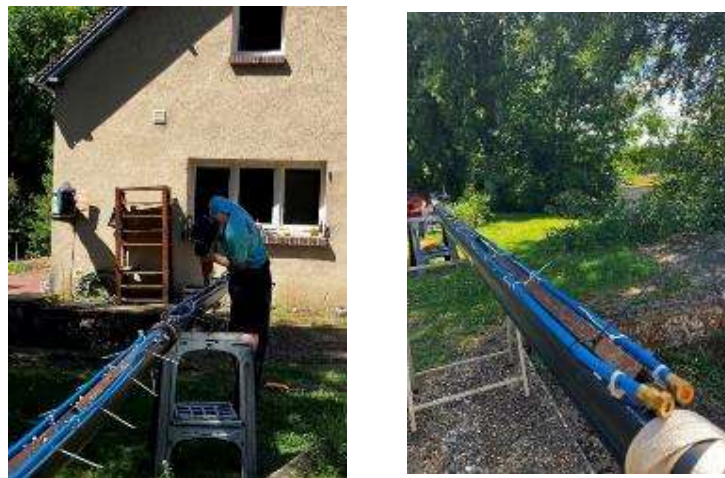
Figure 28 : Photos de la pose des cornières et des barres sur la conduite SWAC
