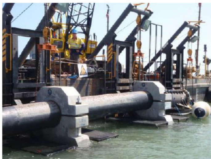
Figure 14 Installation de plusieurs lests à béton simultanément
