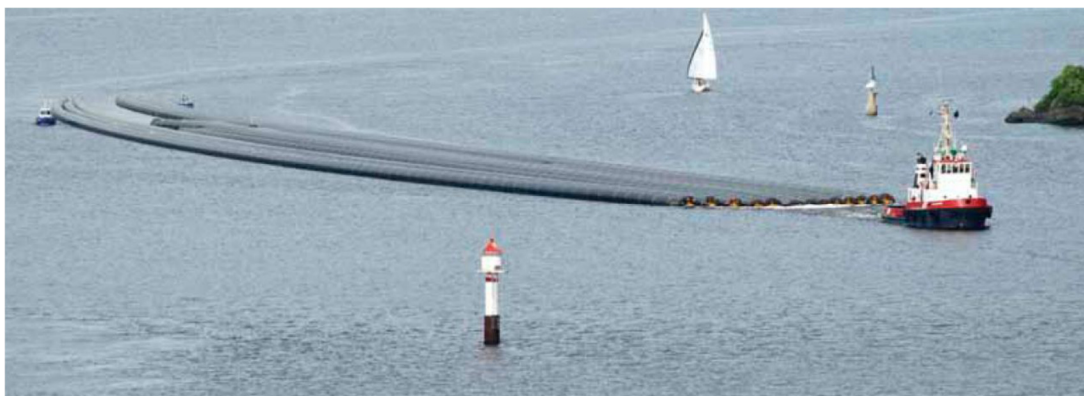
Figure 1 Remorquage de tronçons de conduite jusqu'au site de construction.
